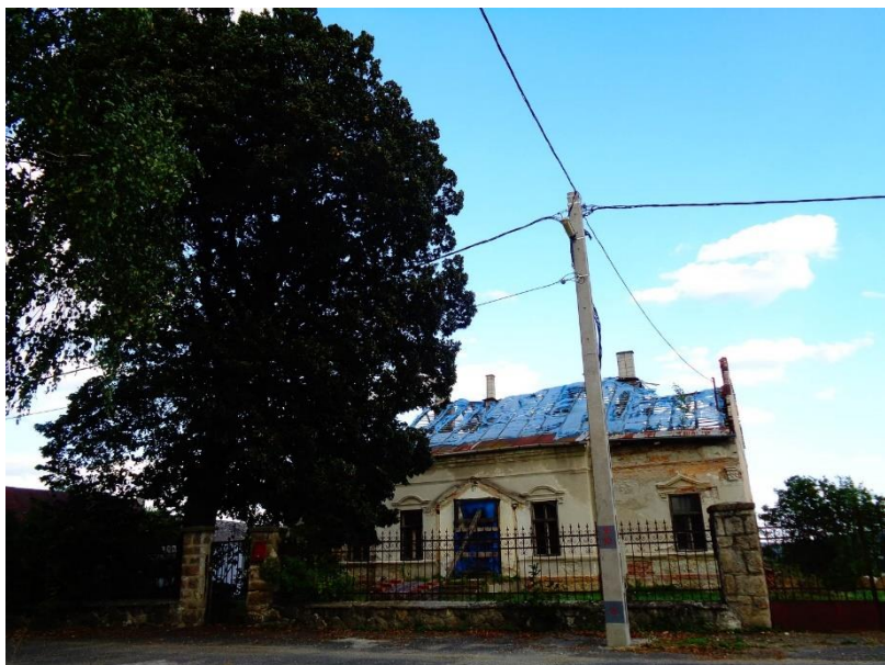
4. Helyi védett épület Népi építészeti emlék- kúria Gazdasor út 23. (78/4 hrsz)
